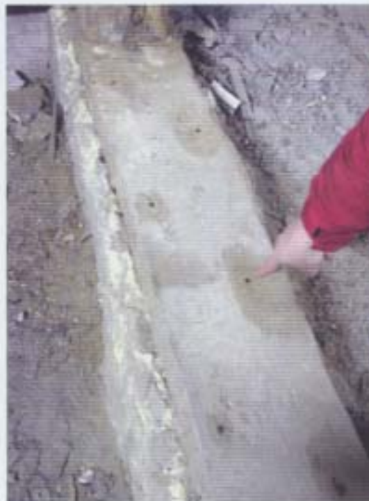
La technique d'injection dans les poutres implique la prise en compte de la section pour le calcul du volume de produit actif à injecter. Le technicien pointe, ici, vers les trous résultant de l'opération.
